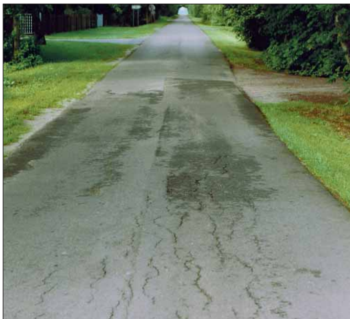
Vejen Scharreler Damm i Tyskland i 1990 før reovering
