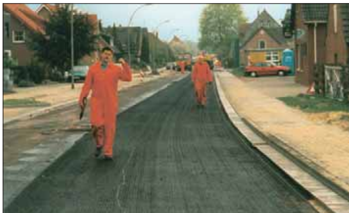
Udlægning af HaTelit® i Ochtrup i Tyskland i 1996
