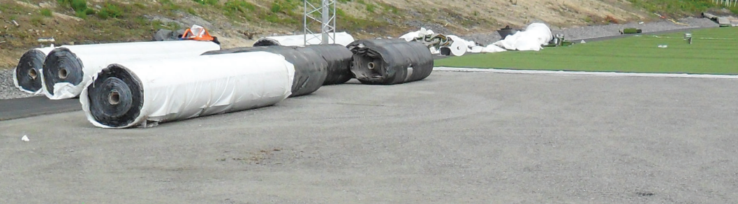
Enkadrain anvendt som gasdræn i deponi.
