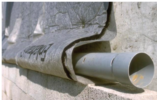
Brug af Enkadrain i forbindelse med kældervæg
