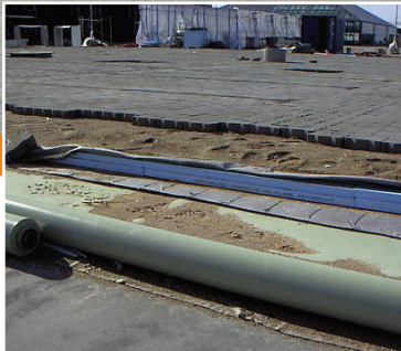
Enkadrain anvendt i forbindelse med parkeringsdæk.
